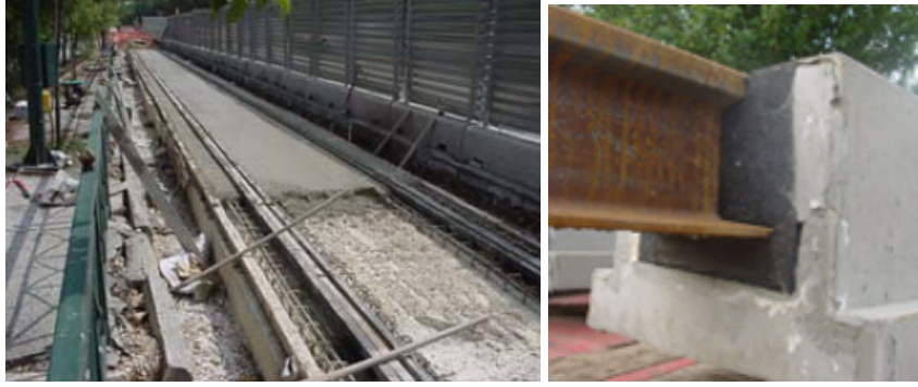
Şekil 1. Gömülü ray sisteminde yerinde beton dökümü.
