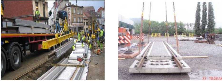
Şekil 2. Prefabrik beton kiriş ve döşeme sistemi.
