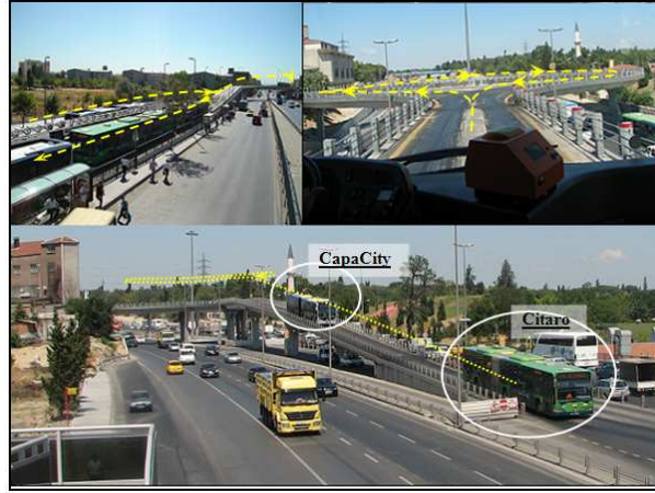
Şekil 2 Avcılar ve Topkapı terminal istasyonlarında dönüş köprüleri.
