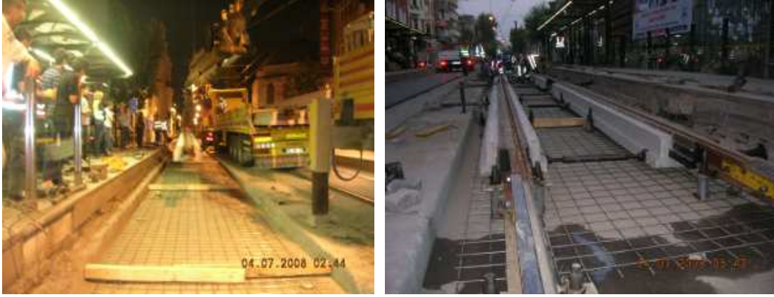
Şekil 3 Hasır çelik ve kiriş betonların döşenmesi.
