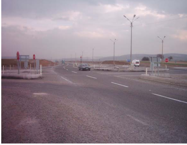
Şekil 4. Kütahya-Tavşanlı karayolunun 16. kilometresindeki kavşak
