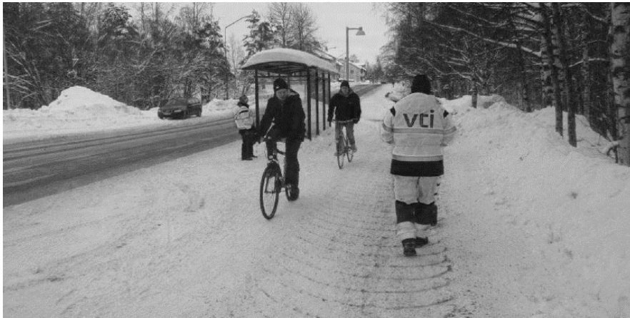
Şekil 5 Sıcak ıslatılmış kumlama yönteminin bisiklet ve yaya yollarına uygulanması.
