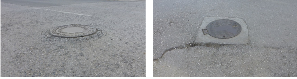
Şekil 4 Rögär kapaklarının yol kotuna göre yüksek kotta yapılan imalat örnekleri.
