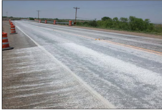
Şekil 7 Kaplama yüzeyine başarılı bir şekilde etki eden kireçli su uygulaması (TxDOT,2004).
