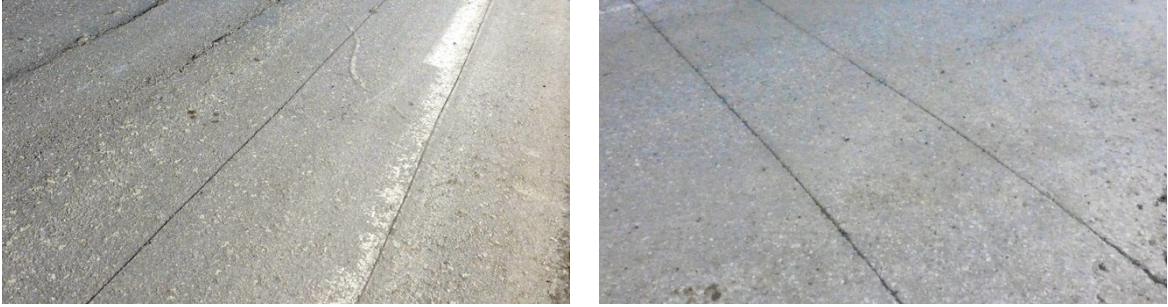
Şekil 7 Yol yüzeyinde oluşturulan kesiklerin örnekleri.
