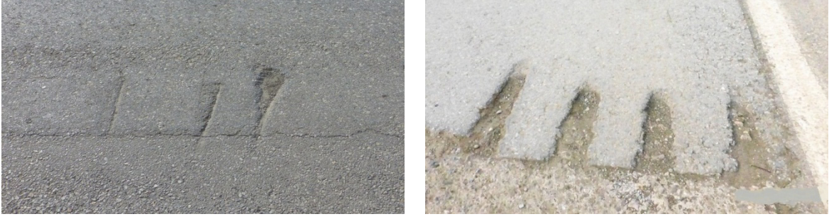
Şekil 6 İş makinelerince oluşturulan hasar örnekleri.
