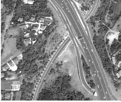
Şekil 5 D-100 Nakkaştepe-Beylerbeyi bağlantısı, Düzenleme öncesi (GoogleEarth).
