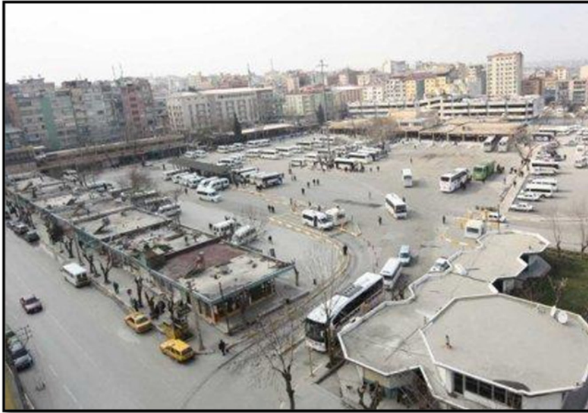
Şekil 1 Denizli Otobüs Terminali'nin yıkılmadan önceki görünümü
