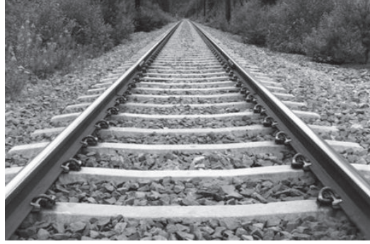
Şekil 2 Balastlı bir yüksek hızlı tren hattı (URL).
