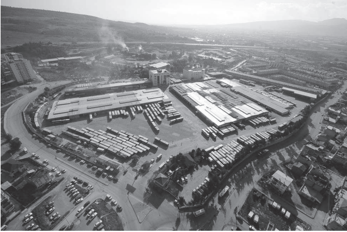
Şekil 3 ESHOT Genel Müdürlüğü-Gediz Garajı ve Atölyesi.
