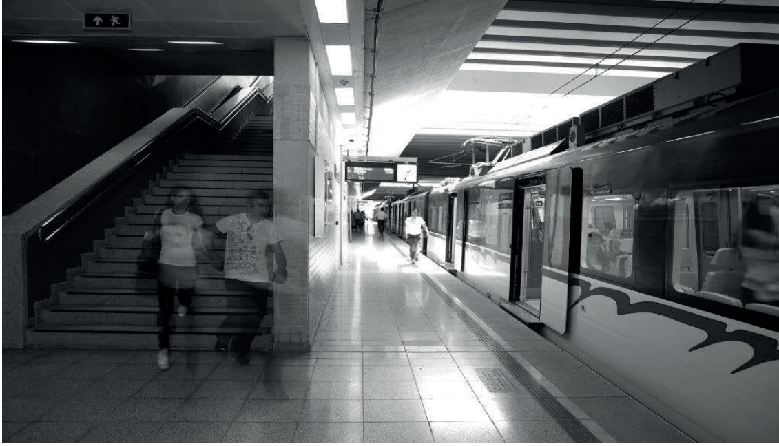
Resim 3 Karşıyaka İstasyon (Tünel İçi Görünüm)
